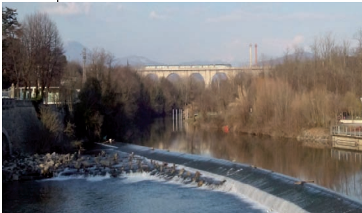
Palazzolo sull'Oglio (BS) – L'ardito ponte di ben nove arcate della linea ferroviaria BG-BS, mentre vi transita un treno locale
